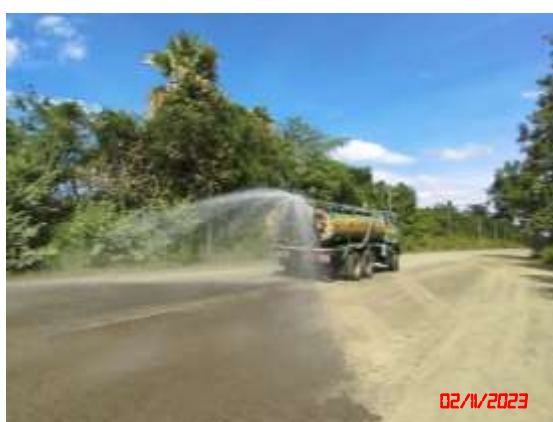
รูปที่ 13 การฉีดพรมน้ำเพื่อลดการฟุ้งกระจายของฝุ่นละออง
